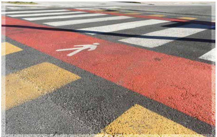
strada da adeguare al limite di velocità. Appare logico sostenere, nel silenzio della normativa circa l'altezza massima o minima delle rampe degli attraversamenti pedonali rialzati, che queste devono essere proporzionate all'altezza dell'attraversamento pedonale.
